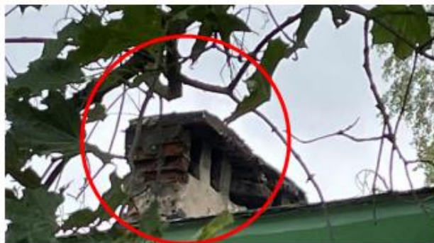
разрушенный оголовок дымовых и вентиляционных каналов
