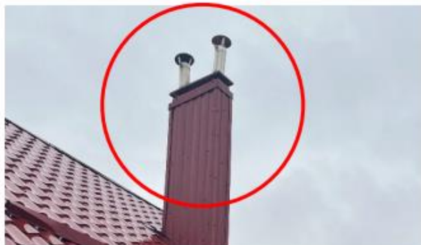
установка зонтов на дымовых каналах
